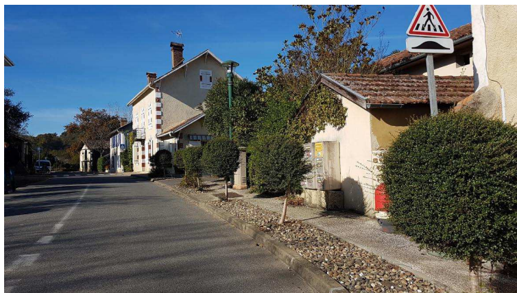
Compacité et alignement sur la voie dans le bourg
